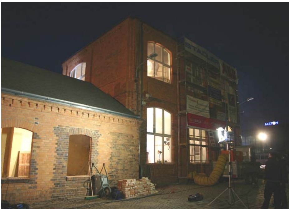
2006: Arbeiten bis spät in die Nacht.
