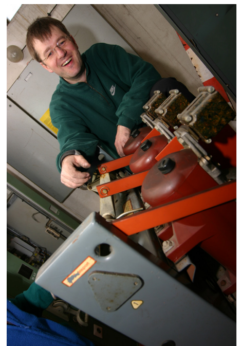
2006: Patrick beim Ausbau der alten Technik.
